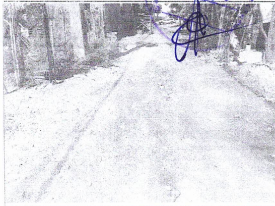
FOTO Nº RUA A 50 DEZEMBRO 2021
