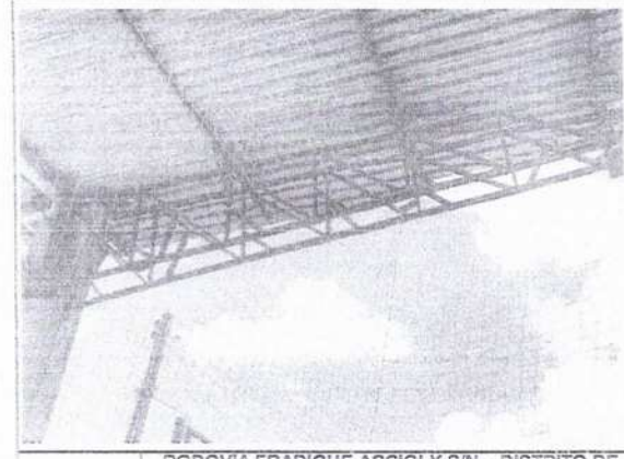
FOTO Nº RODOVIA FRADIQUE ACCIOLY S/N - DISTRITO DE ITACIMA 17 30 DE MAIO DE 2022
