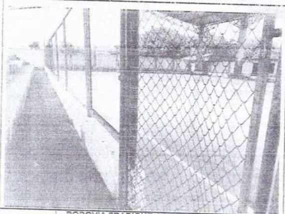
FOTO Nº 25 RODOVIA FRADIQUE ACCIOLY S/N - DISTRITO DE ITACIMA 30 DE MAIO DE 2022
