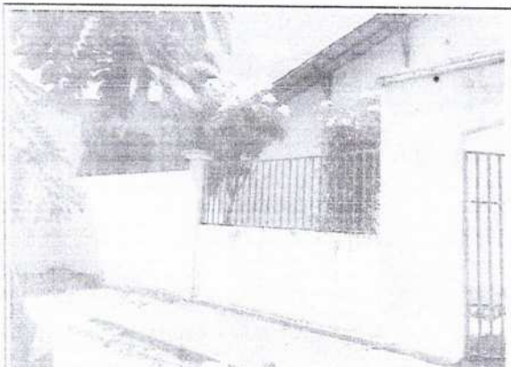
FOTO Nº RODOVIA FRADIQUE ACCIOLY S/N – DISTRITO DE ITACIMA 1 30 DE MAIO DE 2022
