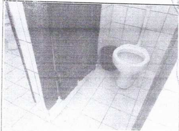
FOTO Nº RODOVIA FRADIQUE ACCIOLY S/N – DISTRITO DE ITACIMA 44 30 DE MAIO DE 2022
