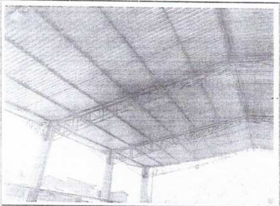
FOTO Nº RODOVIA FRADIQUE ACCIOLY S/N – DISTRITO DE ITACIMA 21 30 DE MAIO DE 2022
