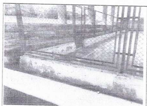
FOTO Nº 30 RODOVIA FRADIQUE ACCIOLY S/N - DISTRITO DE ITACIMA 30 DE MAIO DE 2022
