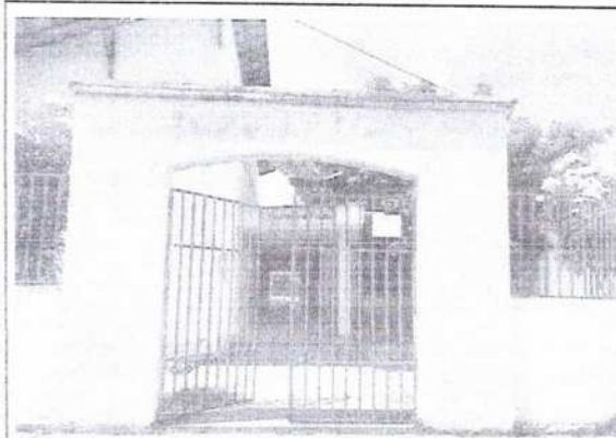
FOTO Nº RODOVIA FRADIQUE ACCIOLY S/N – DISTRITO DE ITACIMA 2 30 DE MAIO DE 2022
