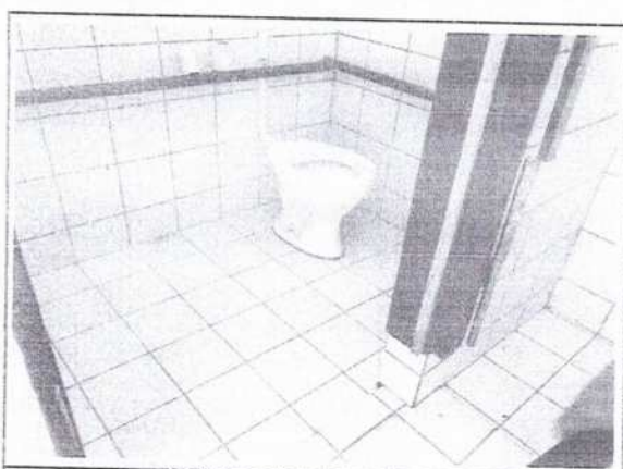
FOTO Nº RODOVIA FRADIQUE ACCIOLY S/N - DISTRITO DE ITACIMA 36 30 DE MAIO DE 2022
