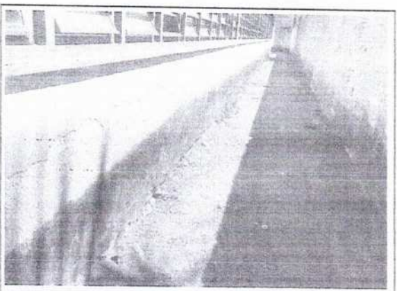
FOTO Nº RODOVIA FRADIQUE ACCIOLY S/N – DISTRITO DE ITACIMA 10 30 DE MAIO DE 2022
