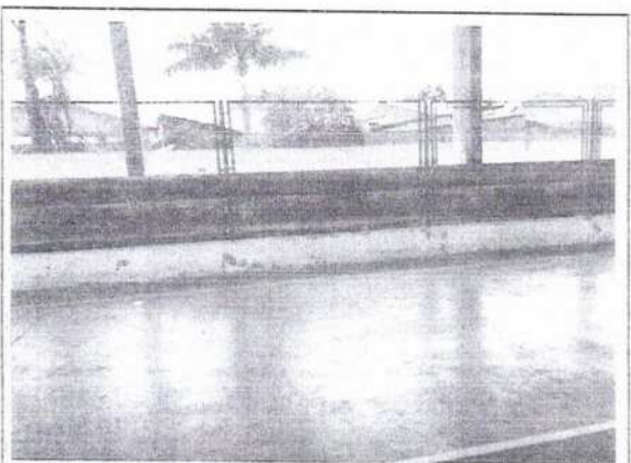
FOTO Nº RODOVIA FRADIQUE ACCIOLY S/N – DISTRITO DE ITACIMA 22 30 DE MAIO DE 2022
