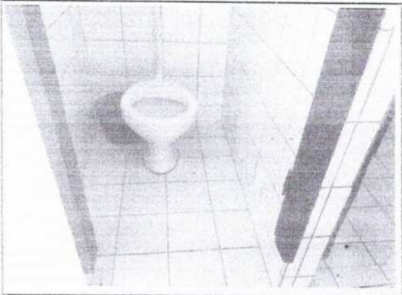
FOTO Nº RODOVIA FRADIQUE ACCIOLY S/N - DISTRITO DE ITACIMA 39 30 DE MAIO DE 2022
