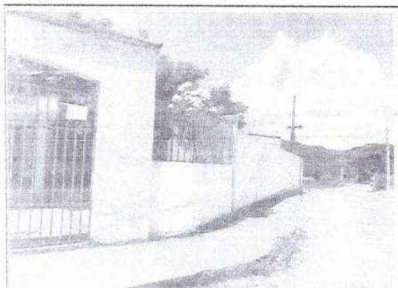
FOTO Nº RODOVIA FRADIQUE ACCIOLY S/N – DISTRITO DE ITACIMA 3 30 DE MAIO DE 2022
