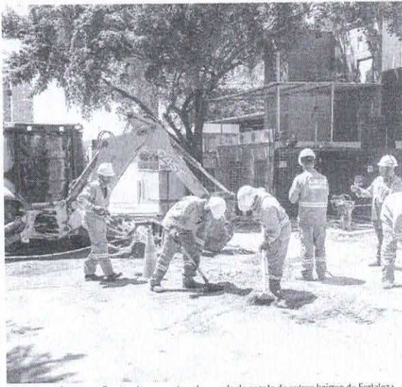
No futuro, projetos semelhantes devem contemplar a rede de esgoto de outros bairros de Fortaleza
