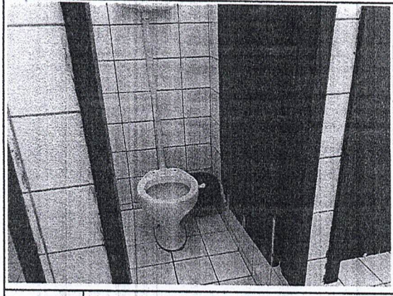
FOTO Nº RODOVIA CE060 S/N – DISTRITO DE ÁGUA VERDE 15 30 DE JANEIRO DE 2023
